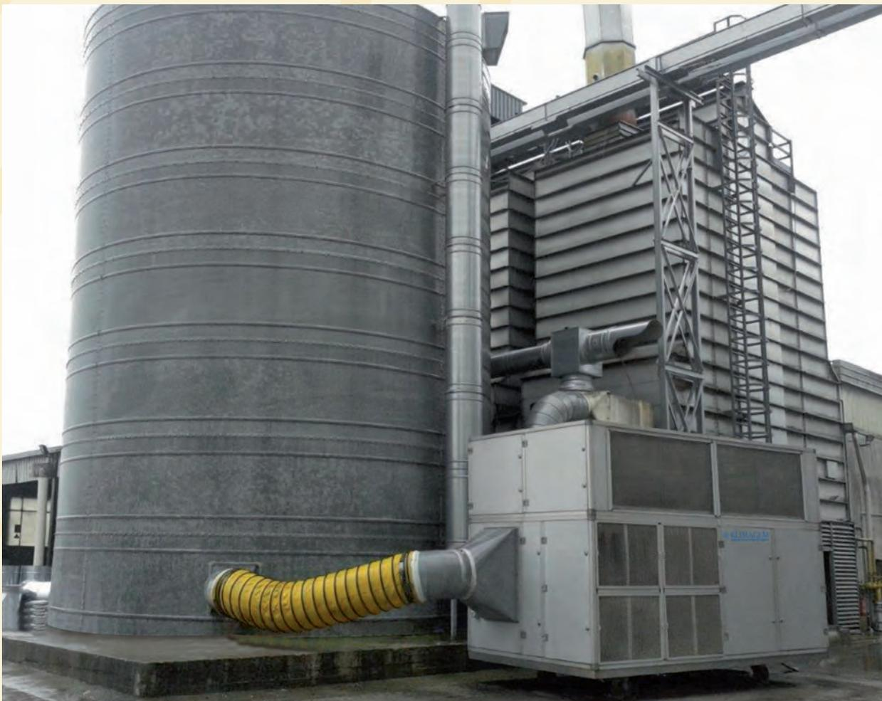
Application avec système de réfrigération KLIMAGRAIN BI-ÉTAGÉ pour températures externes élevées.
